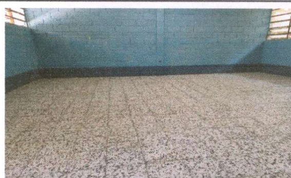
Foto 4: Sustitución de piso de cemento liquido por piso de granito en módulo de aulas 1, 2,3 y 4.
