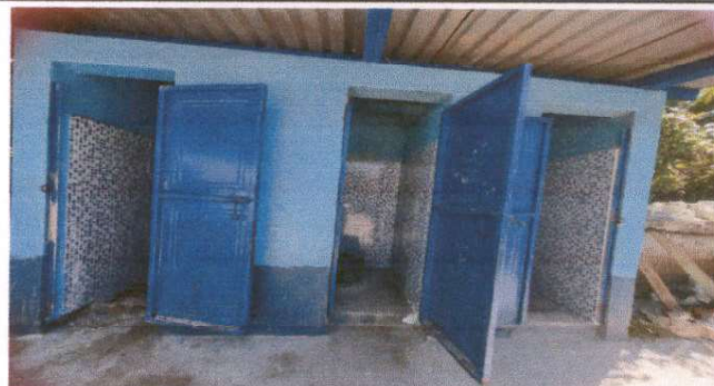
Foto 8: Sustitución de azulejo en módulo de baños.
