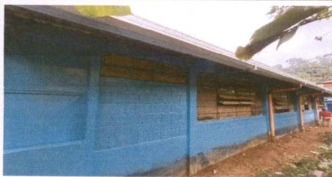
Foto 7: Sustitución de canales de metal por canal galvanizado aluzinc en modulo de aulas parte exterior.
