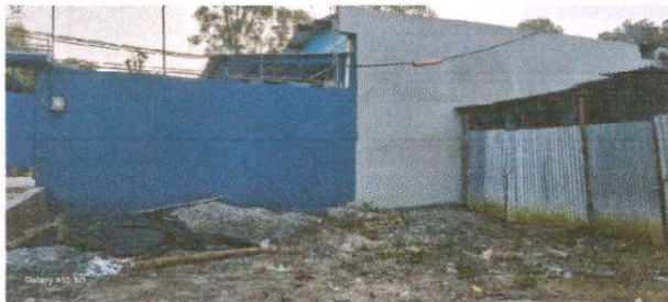
Foto1: Repello y cernido de paredes exteriores del Establecimiento
