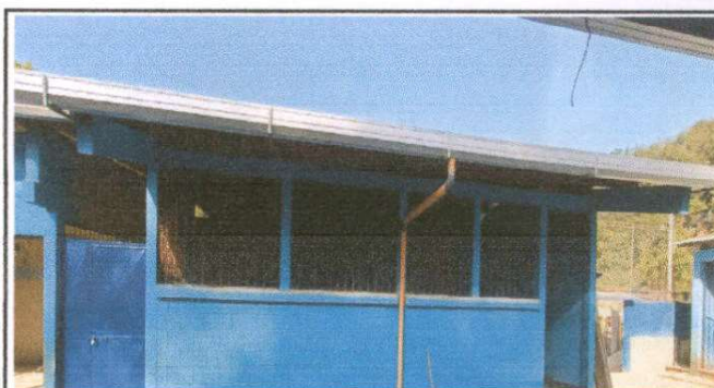
Foto 6: Sustitución de canales de metal por canal galvanizado aluzinc en módulo de aulas parte exterior
